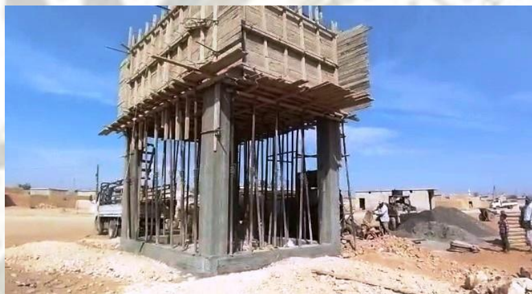
watertoren in aanbouw
